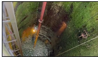
写真-1 集水井撮影状況
